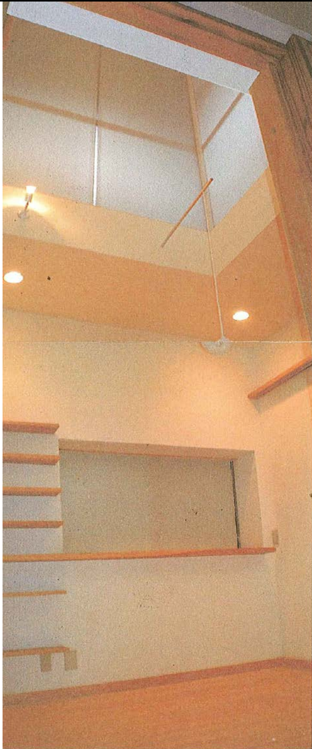
ダイニングルームと上部吹き抜け空間を見る。壁／漆喰左官仕上げ 床／檜縁甲板張り 上部明かり壁／ポリカーボネート
